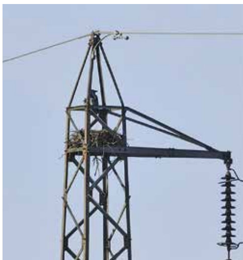
Korpbö i kraftledningsstolpe. Foto: Anders Åkesson.
