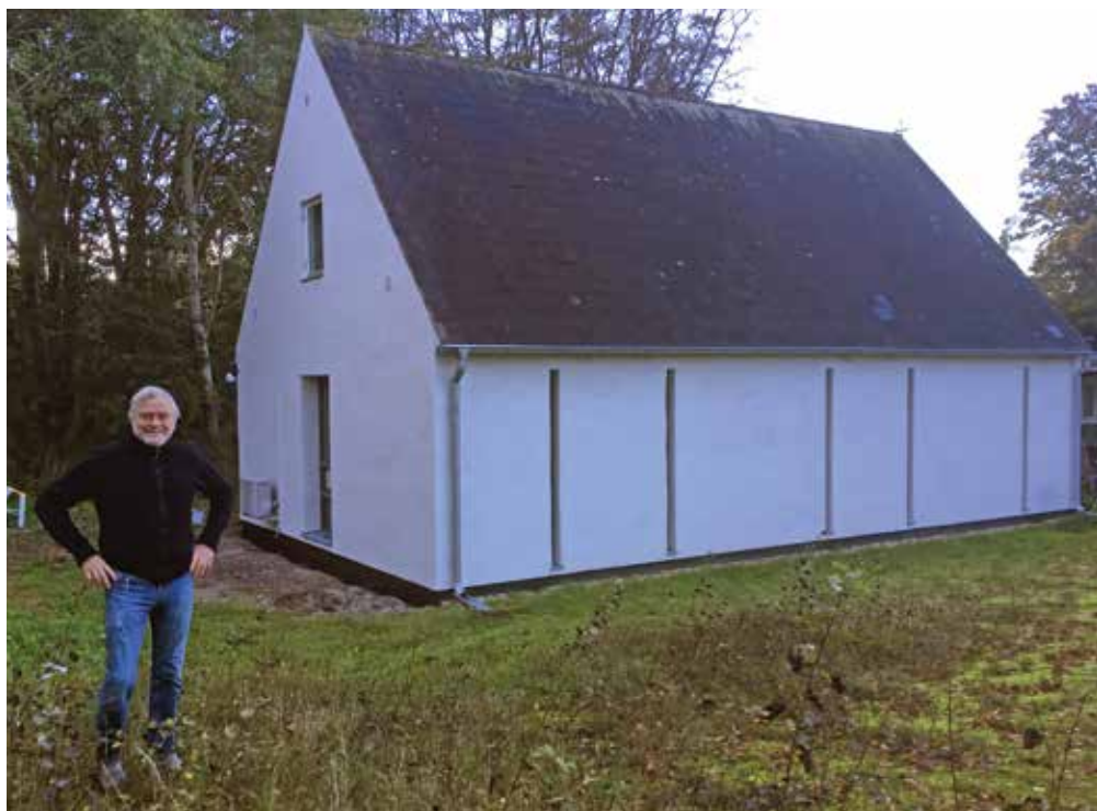
Mikael Kristersson framför den nyrenoverade stationsbyggnaden 11 oktober 2020. Foto: Karin Persson.
