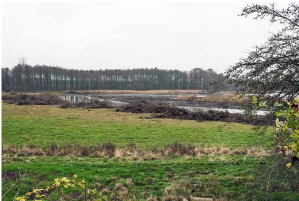
Vy från sydost under restaureringsarbetet i november 2022. Foto: Lars Sundlöf.
