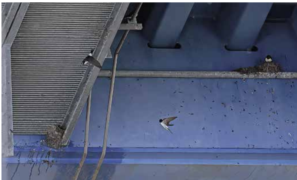
Foto 3: Bonas läge under broöppning. Foto: Bengt Grandin.
