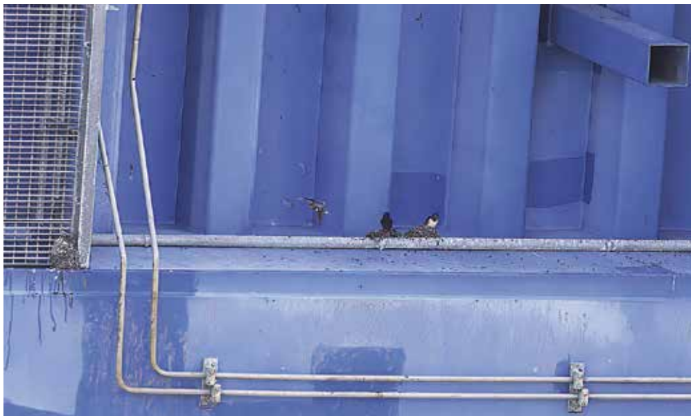
Foto 2: Närbild på bona vid uppfäld bro. Foto: Bengt Grandin.
