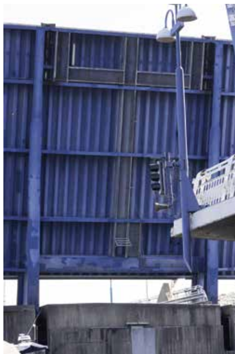
Foto 1: Bron över Falsterbokanalerna i uppfällt läge. Foto: Bengt Grandin.
